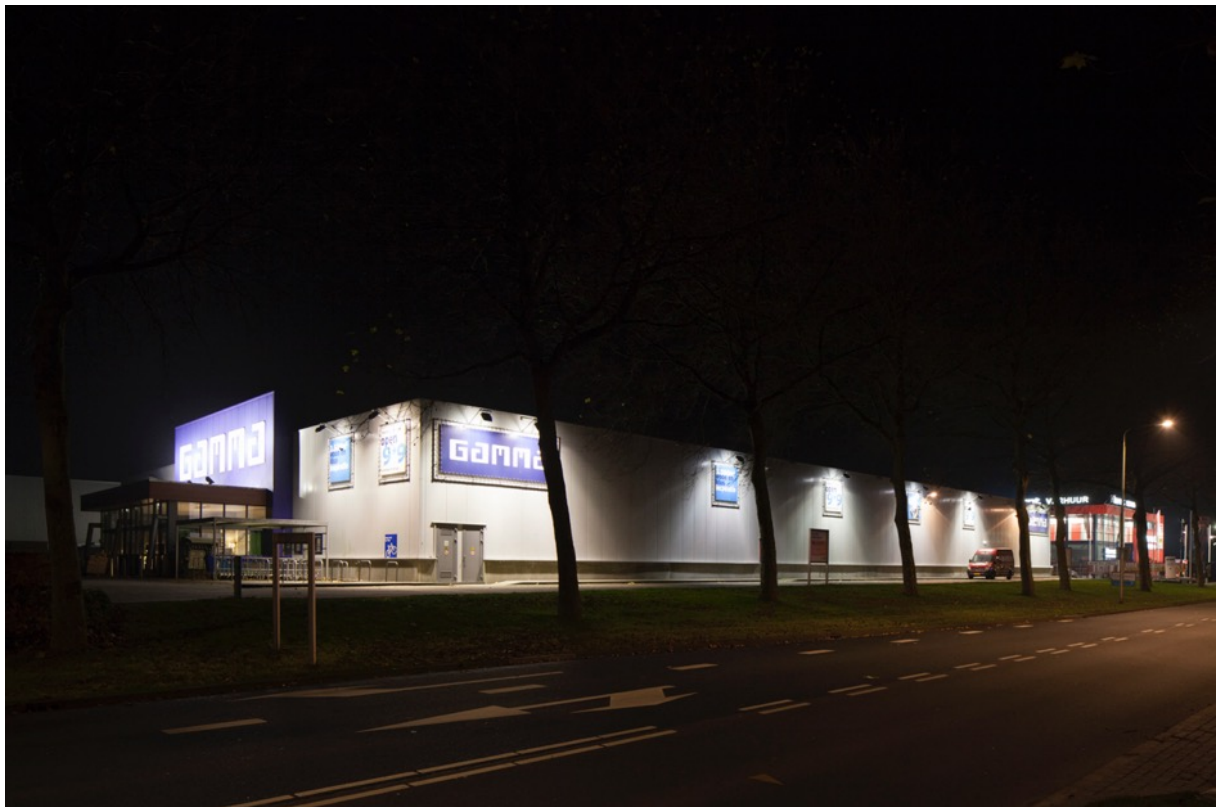
Foto: Randweg in Emmeloord. Fel licht op een pand zodat de straatverlichting wegvalt. Een goede afstemming is belangrijk.
