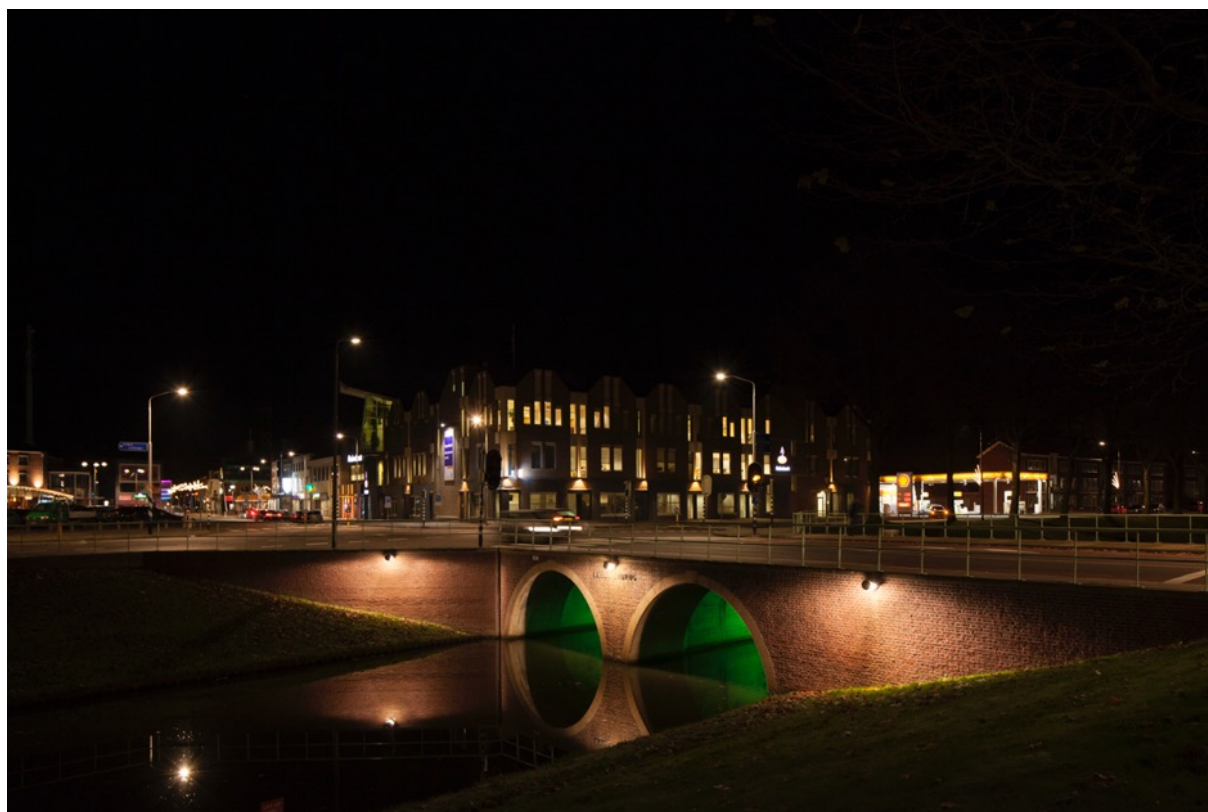
Foto: Nagelerstraat in Emmeloord, brug is hele nacht verlicht.
