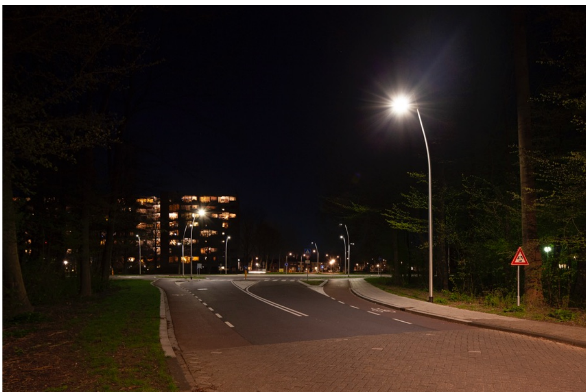
Foto: Rotonde Kometenlaan en Scandinaviëlaan. Licht brandt op halve sterkte tussen 23.00 en 01.00 uur. Van 05.00 uur tot 07.00 uur brandt het licht ook op halve sterkte. Er is minder verkeer op straat, de ogen zijn gewend aan donker, minder lichthinder en we besparen energie.
