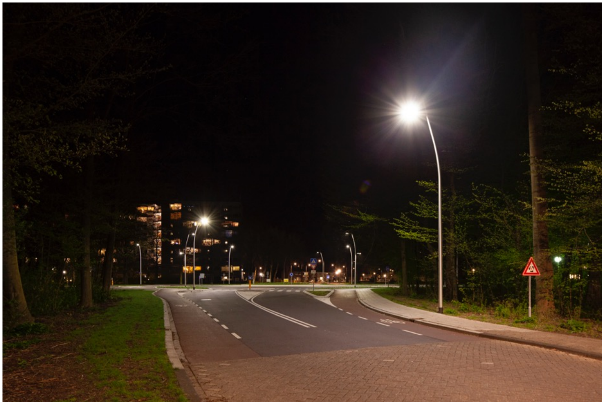
Foto: Rotonde Kometenlaan en Scandinaviëlaan. Licht brandt minder fel (op 75% van volle sterkte) tussen 20.00 tot 23.00 uur omdat er dan minder verkeer op straat is.
