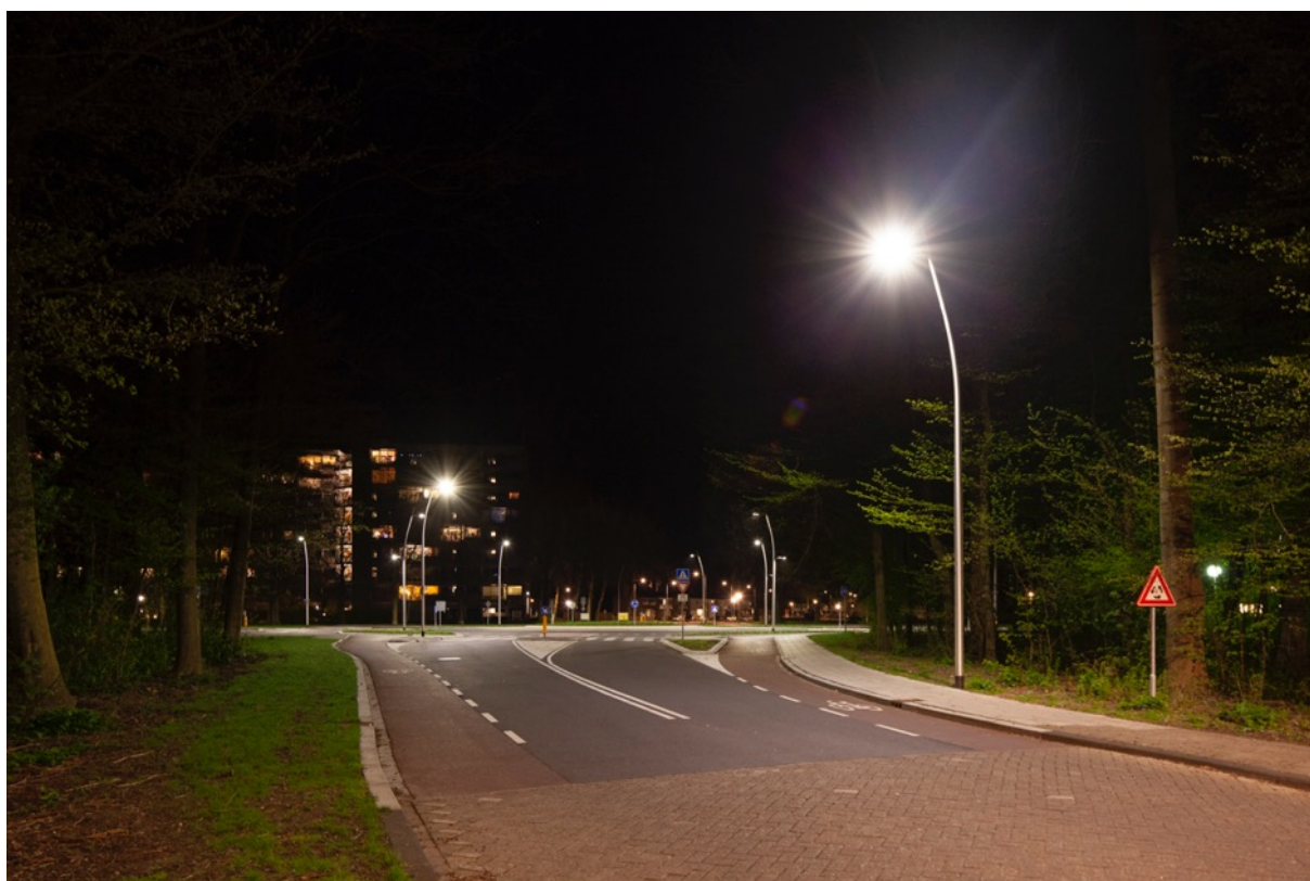
Foto: Rotonde Kometenlaan en Scandinaviëlaan. Licht brandt op volle sterkte tot 20.00 uur. In de ochtend gaat het licht om 07.00 uur ook weer op volle sterkte aan totdat er geen verlichting meer nodig is.
