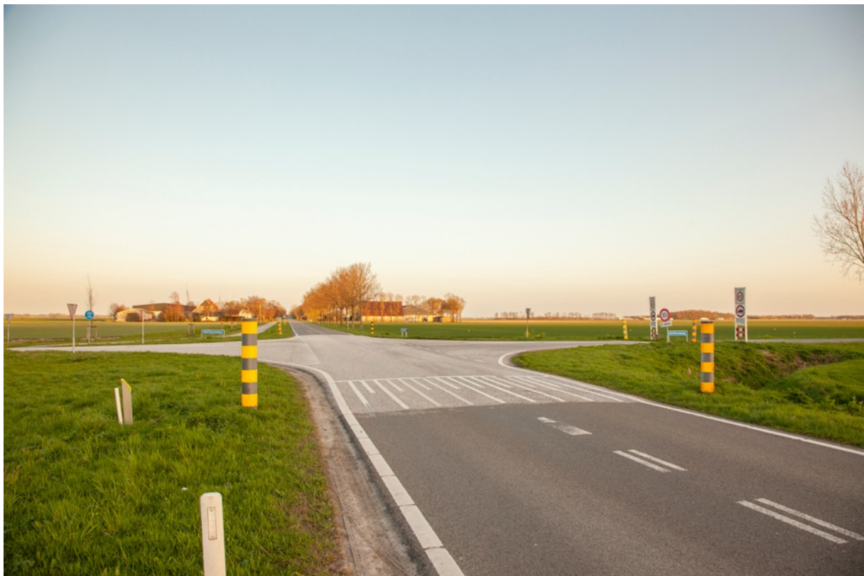
Foto: Zuidwesterringweg, het kruisingsvlak is voorzien van een witte toplaag waardoor het een attentiewaarde heeft.
