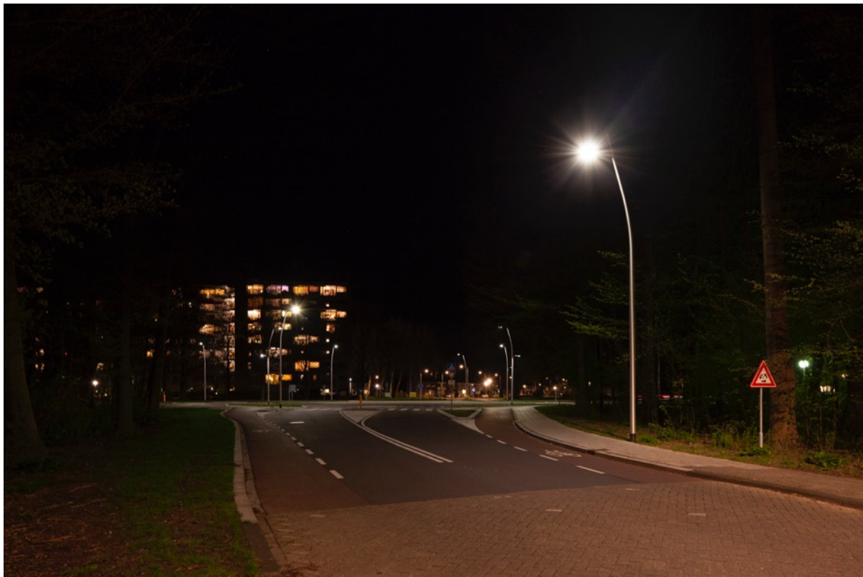
Foto: Rotonde Kometenlaan en Scandinaviëlaan. Licht brandt op 30% tussen 01.00 en 05.00 uur. Er is nog minder verkeer op straat, de ogen zijn nog beter gewend aan het donker, zo is er minder lichthinder en we besparen energie.
