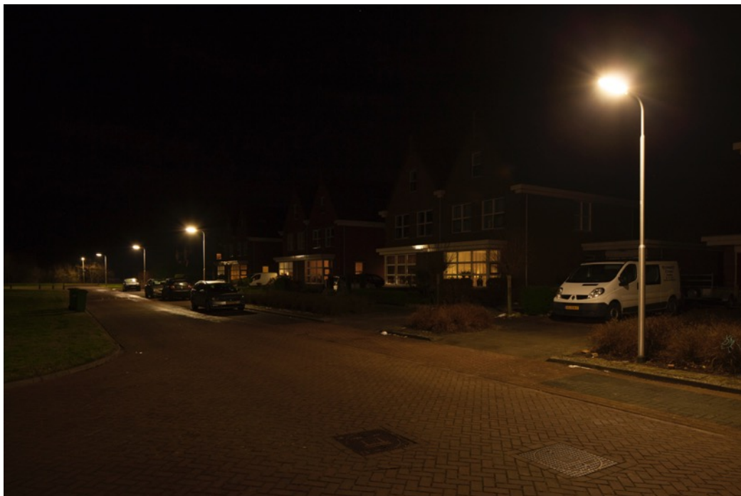
Foto: Basiel in Rutten. Licht is gelijkmatig over de weg verdeeld zodat er geen zwarte vlekken zijn.
