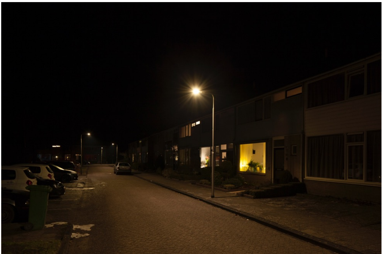
Foto: Iglo Tadastraat in Creil, woonstraat met witte verlichting voor goede kleur- en gezichtsherkenning.
