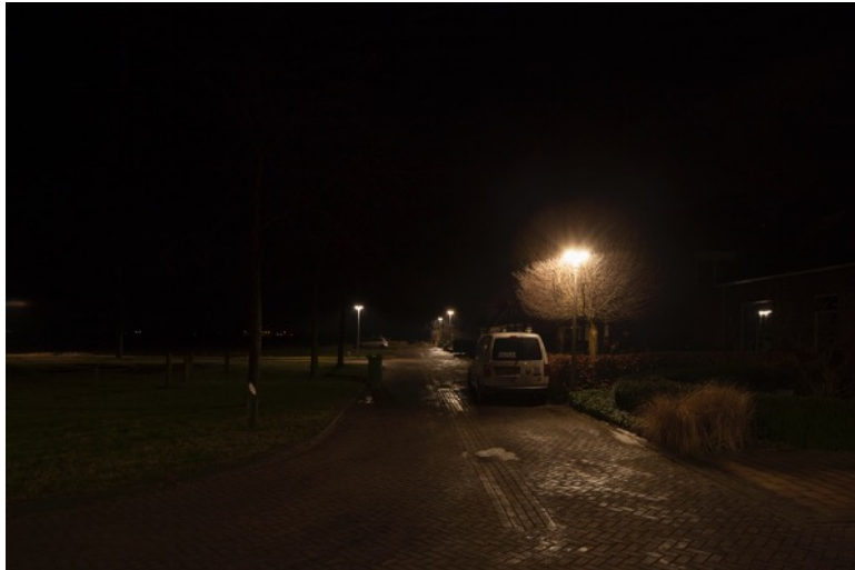
Foto: Buizerstraat in Creil. Lantaarnpaal staat in de boom waardoor (als er blad aan de boom is) het licht in de boom verdwijnt en niet op de straat schijnt.
